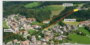
Abb. 22: Bergstation St. Andrä Station am Parkplatz und Schrägaufzug S. 34
